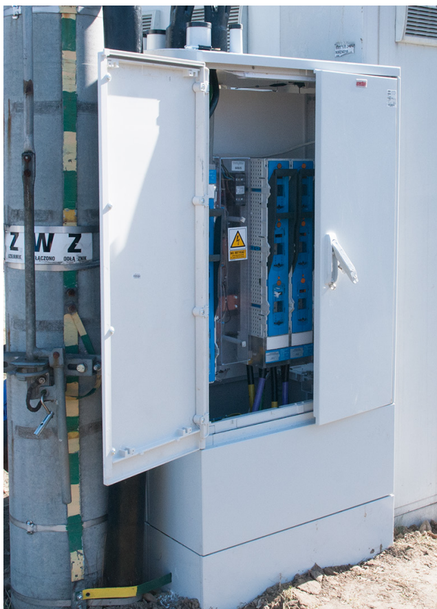
Rys. 4. Obudowa STTF wykonana z tworzywa poliestrowego
